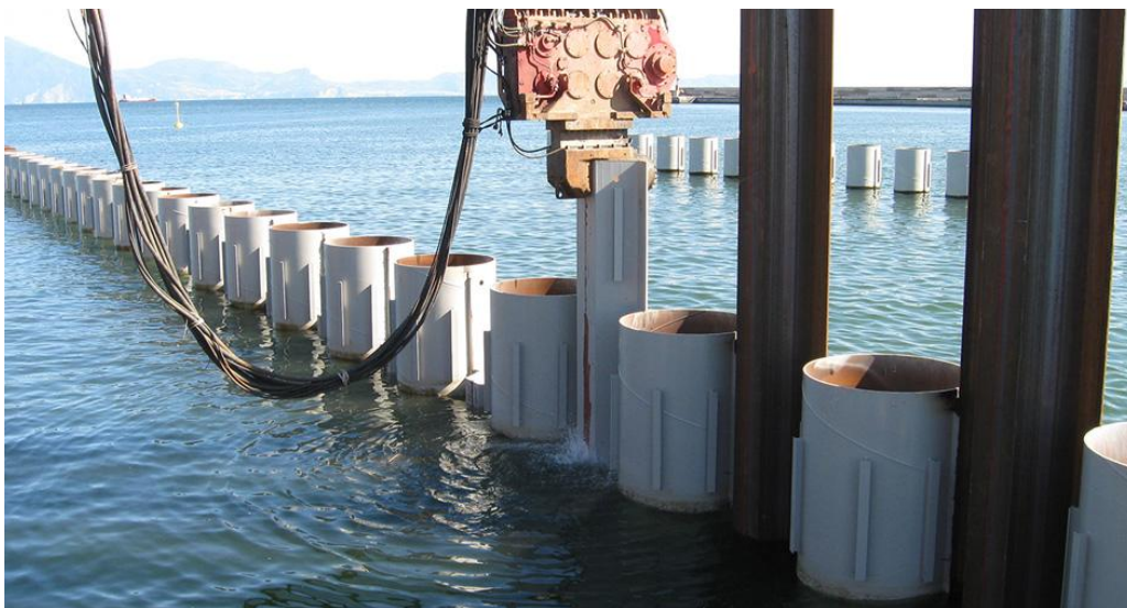
(port of Vlora, bulding new quay.)
